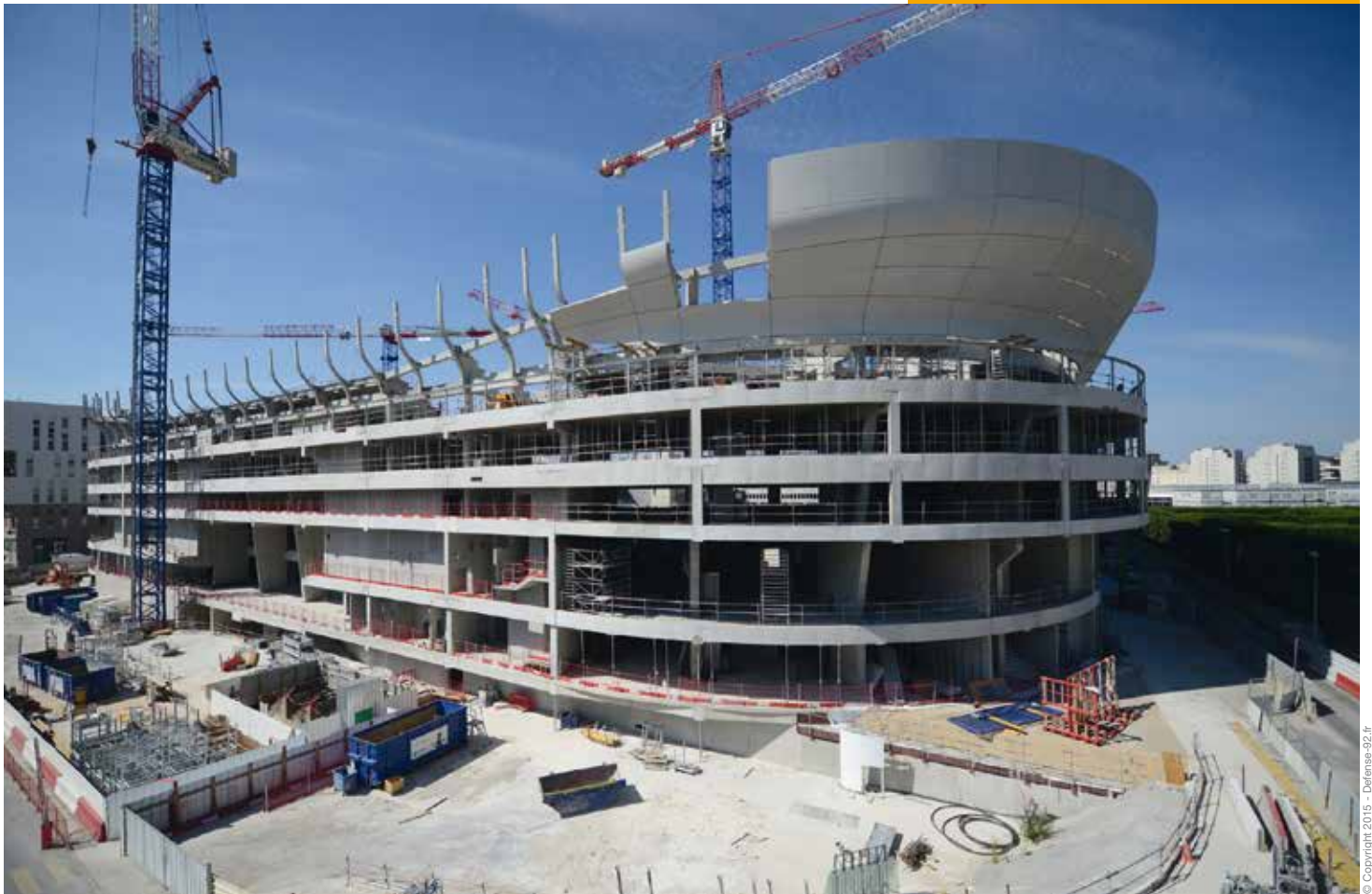
Mise en place des 400 coques de la couronne de béton blanc de l'Arena Nanterre-La Défense.
