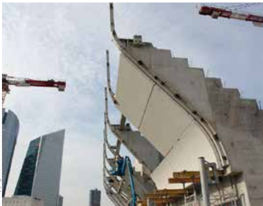
Montage des éléments préfabriqués par l'entreprise JOUSSELIN Préfabrication, en surface des gradins de tribunes de l'Arena Nanterre-La Défense.
